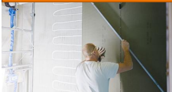
Tag 6 | Innenausbau Bad
